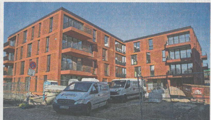
Derzeit arbeiten die Handwerker am Innenausbau: Im März werden die Familien ihr Mehrgenerationenhaus beziehen.
