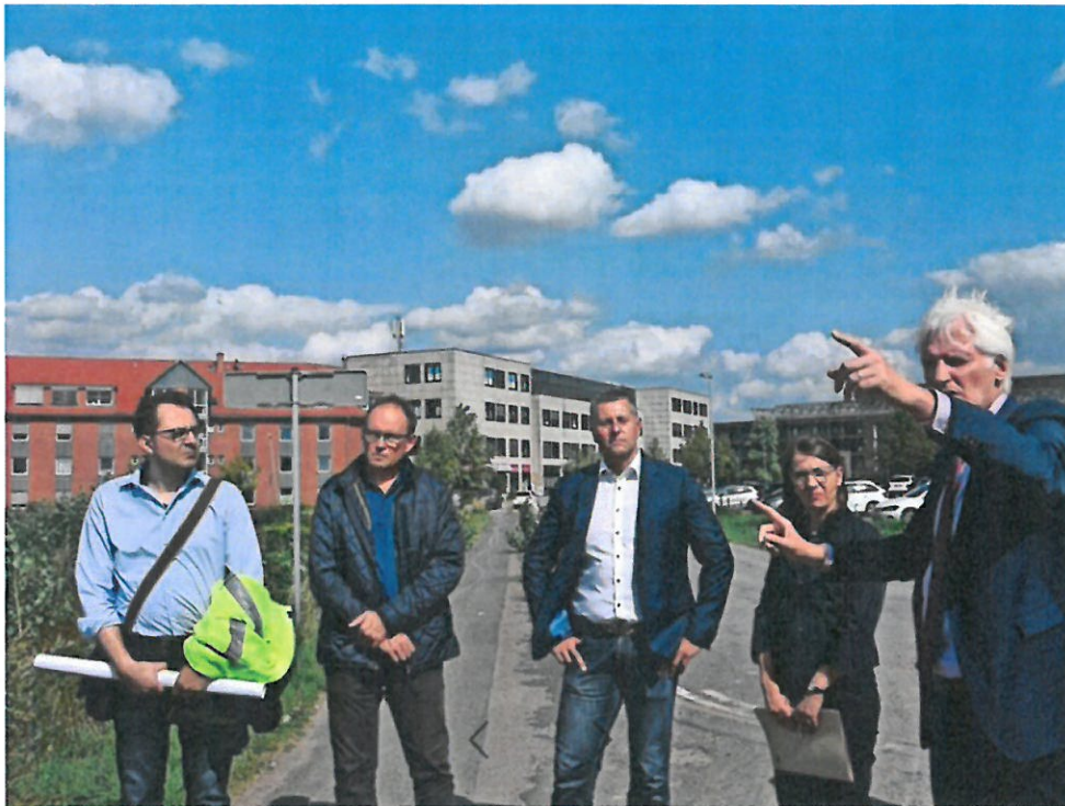
"Hier entsteht die Achse zwischen Europaallee und Neuer Mitte": Bürgermeister Christian Grahl besichtigt die Baustelle für die Wohnbebauung. Quelle: Linda Tonn
