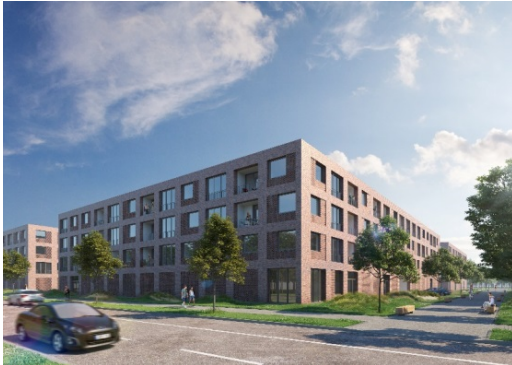
Foto 1: Wohnprojekt Europaallee – Neue Mitte Garbsen Quartier
