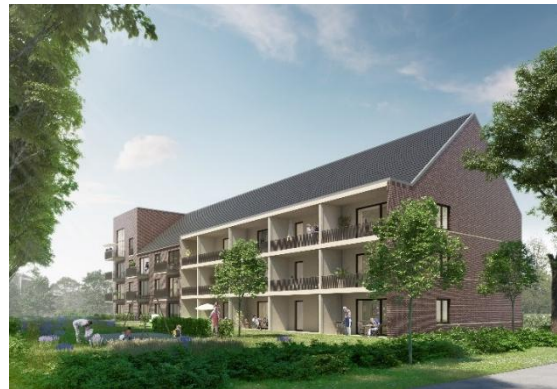
Mehrfamilienhaus 4. BA – Ansicht von Südosten
