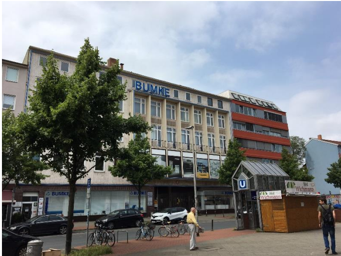
Gebäudeansicht Engelbosteler Damm 5, Hannover-Nordstadt
